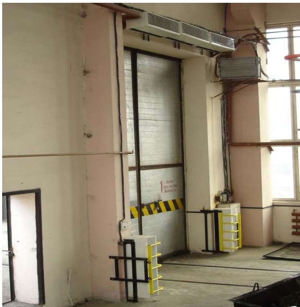
Рис. 3.1. Воздушно-тепловая завеса
